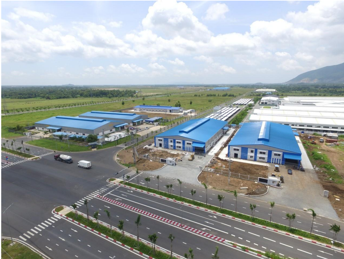
Một góc Khu công nghiệp Châu Đức
