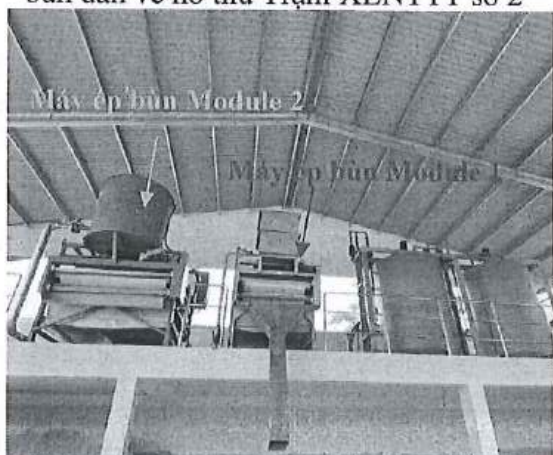
Hình 2. 9. Nhà ép bùn Trạm XLNTTT số 02
